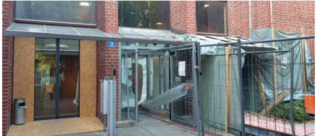
Der Aufzug wird am Nebeneingang an der östlichen Seite des Rathauses eingebaut. Auch dieser Zugang wurde verlegt.
